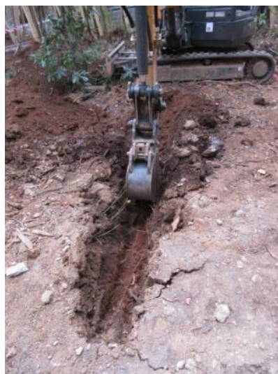
Foto 116. Excavació Rasa 45. Vista des de l'est.
