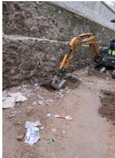
Foto 42. Excavació Rasa 9. Vista des del sud.
