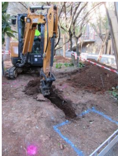
Foto 117. Excavació Rasa 46. Vista des del sud.
