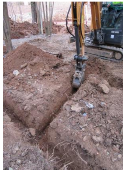
Foto 80. Excavació Rasa 23. Vista des del nord-oest.
