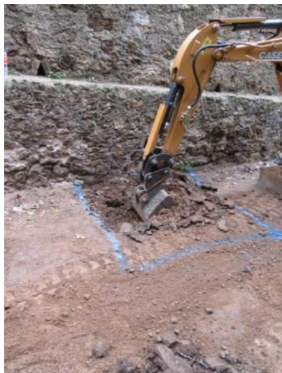
Foto 45. Excavació Rasa 10. Vista des del sud.
