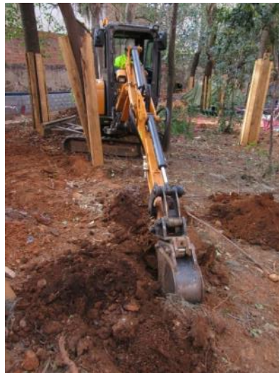
Foto 114. Excavació Rasa 44. Vista des del sud-est.
