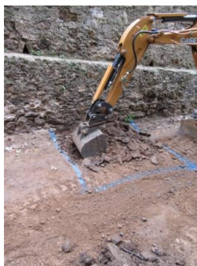
Foto 48. Excavació Rasa 11. Vista des del sud.
