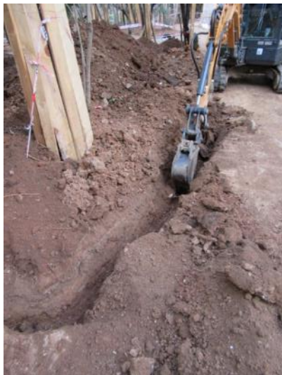
Foto 89. Excavació Rasa 28. Vista des del sud-oest.
