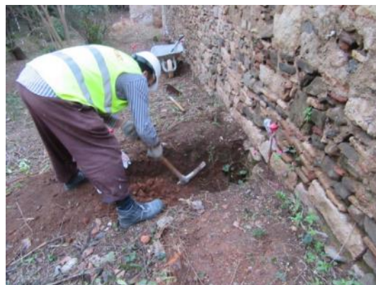
Foto 2. Excavació Rasa 1. Vista des del sud.
