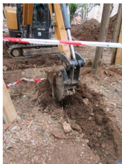
Foto 76. Excavació Rasa 21. Vista des del sud-oest.
