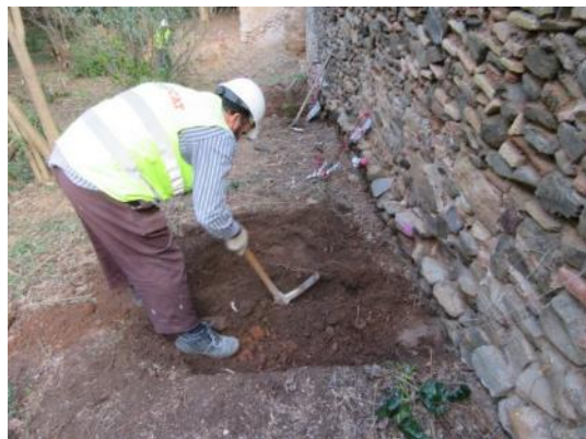
Foto 5. Excavació Rasa 2. Vista des del sud.
