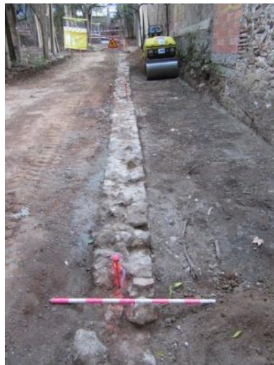
Foto 22. Tram final mur UE 7. Vista des del nord.
