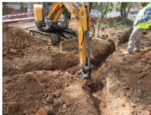
Foto 94. Excavació Rasa 29. Vista des del nord-est.
