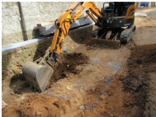
Foto 69. Excavació Rasa 18. Vista des del sud-oest.
