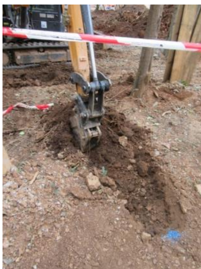
Foto 87. Excavació Rasa 27. Vista des de l'est.
