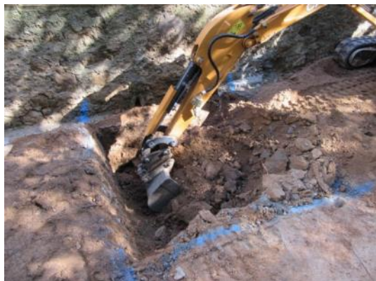
Foto 57. Excavació Rasa 14. Vista des del sud.
