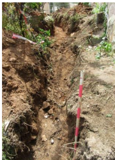
Foto 38. Final tram inicial Rasa 8. Vista des del nord-oest.
