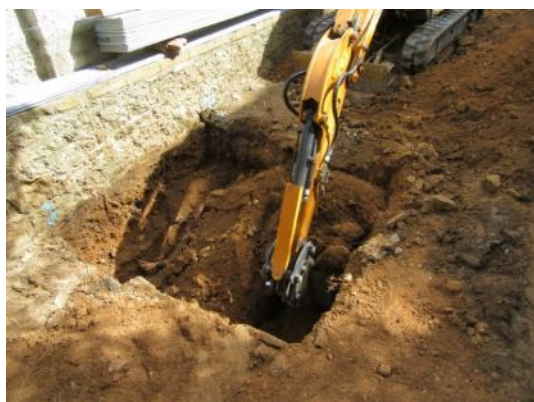
Foto 63. Excavació Rasa 16. Vista des del sud-oest.
