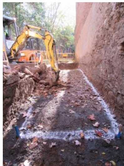
Foto 32. Desmuntatge parcial UE 7. Vista des del nord-oest.
