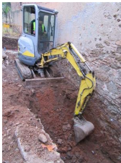
Foto 18. Excavació Rasa 6. Vista des del nord.
