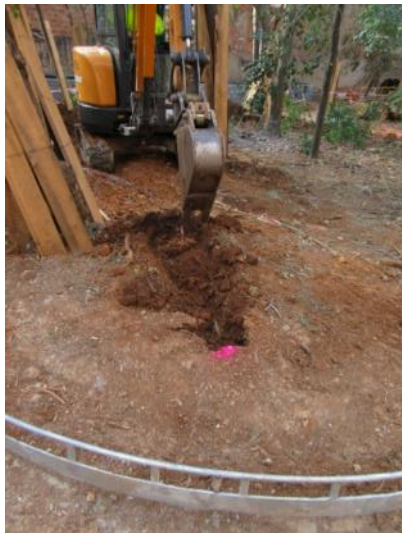
Foto 113. Excavació Rasa 43. Vista des del nord-oest.
