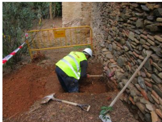
Foto 8. Excavació Rasa 3. Vista des del sud.
