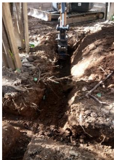
Foto 83. Excavació Rasa 25. Vista des de l'est.
