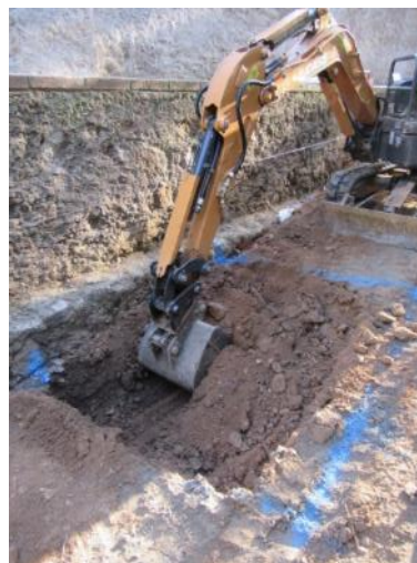
Foto 54. Excavació Rasa 13. Vista des del sud-oest.
