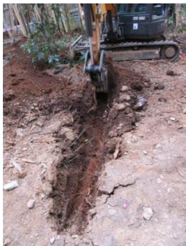
Foto 107. Excavació Rasa 39. Vista des del sud-est.
