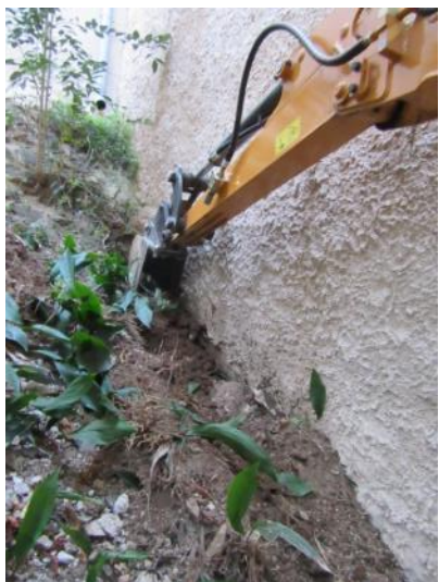
Foto 11. Excavació Rasa 4. Vista des del nord-oest.
