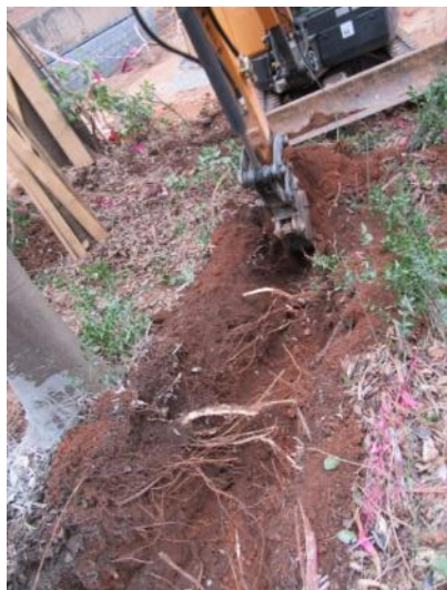
Foto 105. Excavació Rasa 37. Vista des de l'est.
