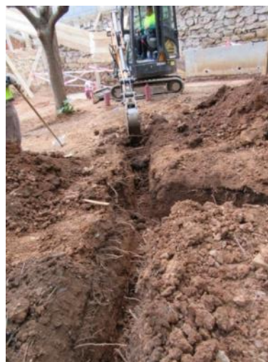
Foto 72. Excavació Rasa 19. Vista des del nord
