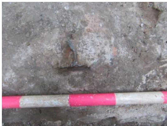
Foto 25. Detall de les restes d'una bigueta de ferro al tram central del mur UE 7. Vista zenital.
