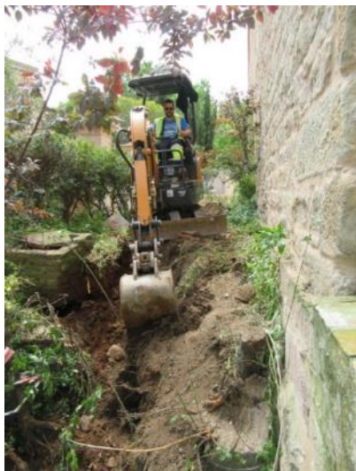
Foto 37. Excavació Rasa 8. Vista des del nord-oest.
