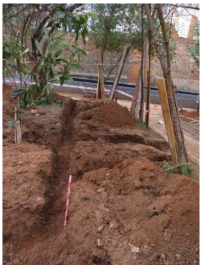
Foto 119. Final Rases 37, 38, 42 i 43. Vista des de l'est.
