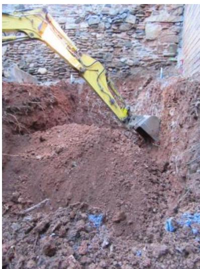
Foto 35. Excavació Rasa 7. Vista des del sud-oest.
