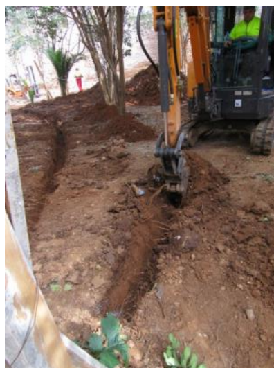
Foto 74. Excavació Rasa 20. Vista des del nord
