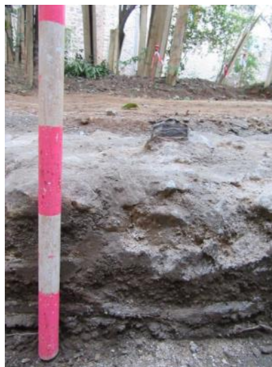
Foto 26. Detall de les restes d'una bigueta de ferro a l'extrem sud del mur UE 7. Vista des de l'oest.
