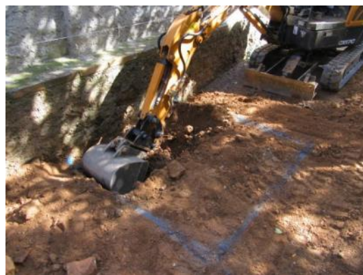
Foto 60. Excavació Rasa 15. Vista des del sud-oest.
