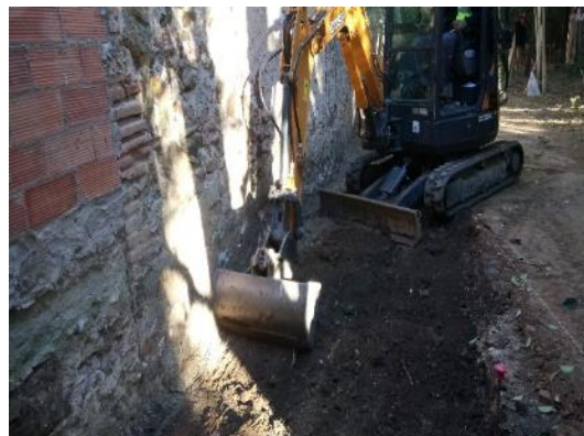
Foto 122. Excavació Rebaix 1 al tram central. Vista des del sud.
