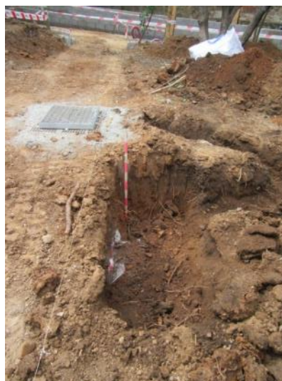
Foto 104. Final Rasa 36 i, en primer terme extrem sud de la Rasa 32. Vista des de l'est.
