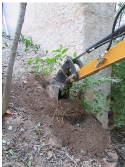
Foto 14. Excavació Rasa 5. Vista des del nord.
