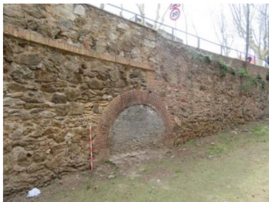
Foto 29. Ull de pont tapiat, vist des del torrent de Carabassa. Vista des del nord-oest.
