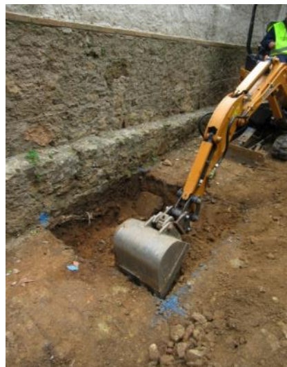
Foto 66. Excavació Rasa 17. Vista des del sud-oest.
