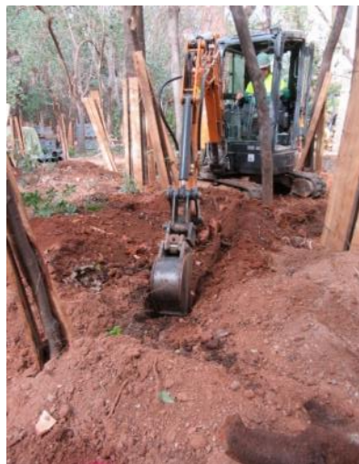
Foto 108. Excavació Rasa 40. Vista des del sud.
