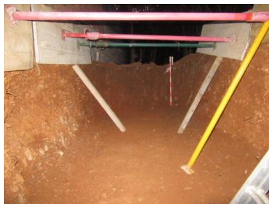
Foto 36. Final Rasa 7. Vista des del nord-est.
