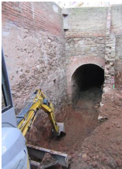
Foto 19. Excavació Rasa 6. Vista des del sud-est.
