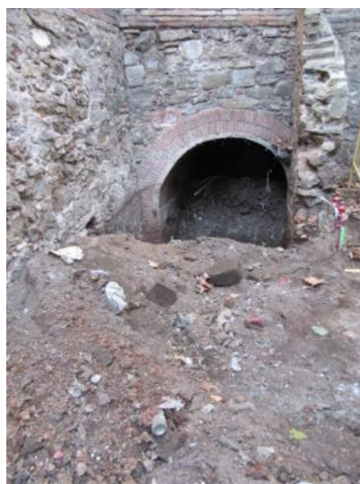
Foto 16. Inicial Rasa 6 a la zona on el torrent canalitzat passa per sota el carrer Peris i Mencheta. Vista des del sud-est.
