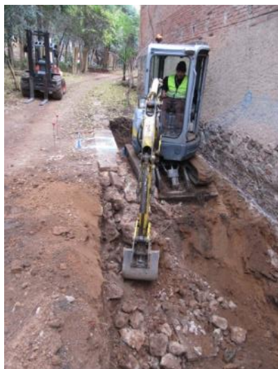
Foto 31. Desmuntatge parcial del mur UE 7. Vista des del nord.
