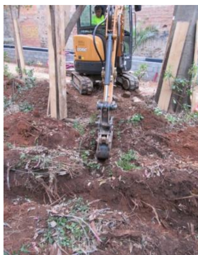
Foto 112. Excavació Rasa 42. Vista des de l'est.
