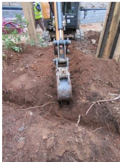
Foto 110. Excavació Rasa 41. Vista des de l'est.
